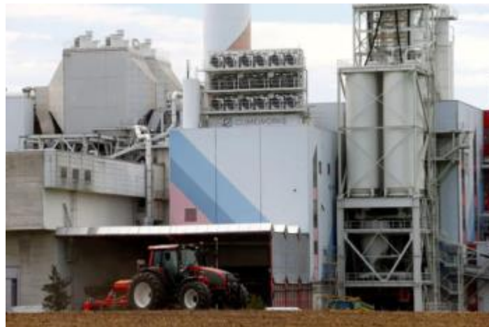
2017年7月18日、スイスのヒンヴィルにある廃棄物焼却プラントの屋上に設置された、空気中の二酸化炭素を回収する施設。現在稼働している一握りの実証プロジェクトの一つである。
