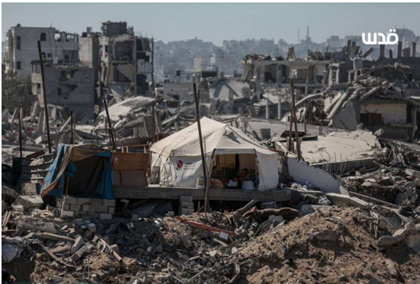
ガザ北部ジャバリヤで大規模な破壊が発生。(Photo: via QNN)
